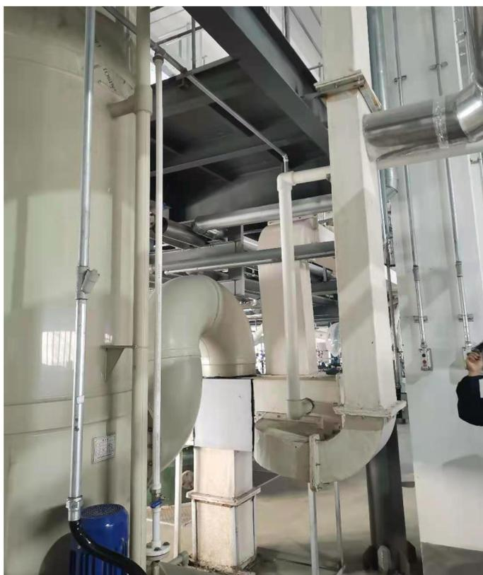
图片：车间废气处理设施进口管线连接复杂无开孔位置
