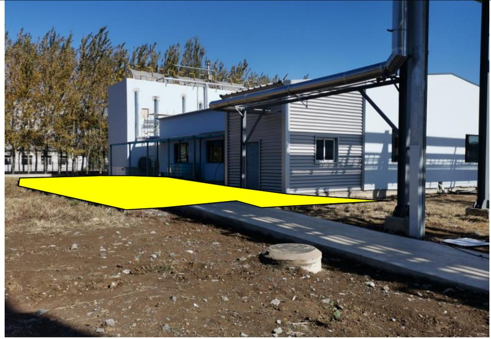
图上建筑为污水处理站，黄色部分，地下即事故水池。
